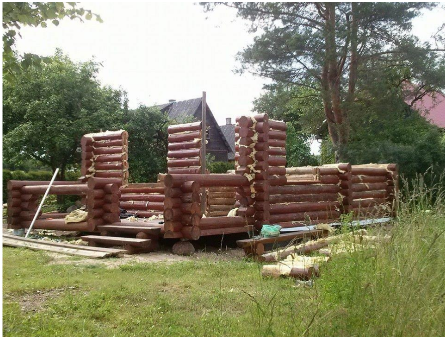
Joonis 20. Palkmaja paigaldus, kahe päeva töö.
