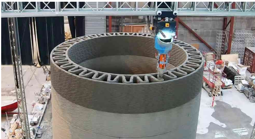
Joonis 6. 3D prinditud betoonist struktuur.[9]
