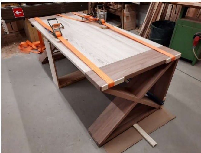
Joonis 10. Plaatide jalgade vahale kinnitamine
