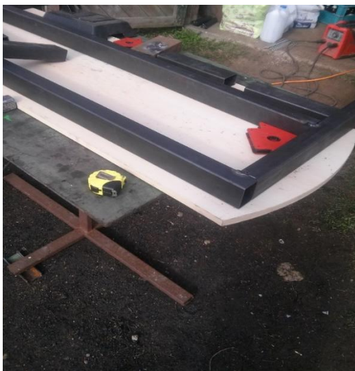
Joonis 15. Vertikaalselt asuvate jalgade keevitus horisontaalse välikülgedel asetseva ristküliktoru külge
