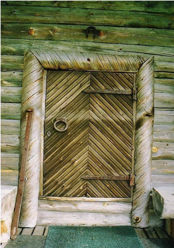
Joonis 3. Kalkiuline palk kasutusel uksepiidana vanas talumajas (foto: erakogu).
