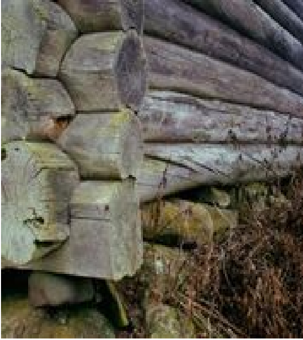
Joonis 2. Kalkiuline palk vanas palkmajas (foto: erakogu).
